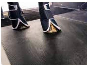
Plancher recouvert d'un caoutchouc antidérapant
